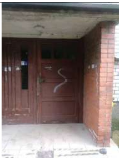
Kāpņu telpas ārdurvis
